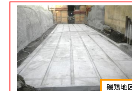
ボックスカルバートを設置するための基礎となるコンクリートの打設が完了しました。
